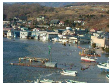
図 D-11. 東日本大震災における様似漁港の被害状況
